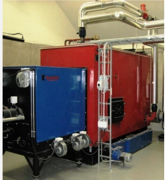
Laka PS-500 kW kattila ja Biofire hakepoltin
